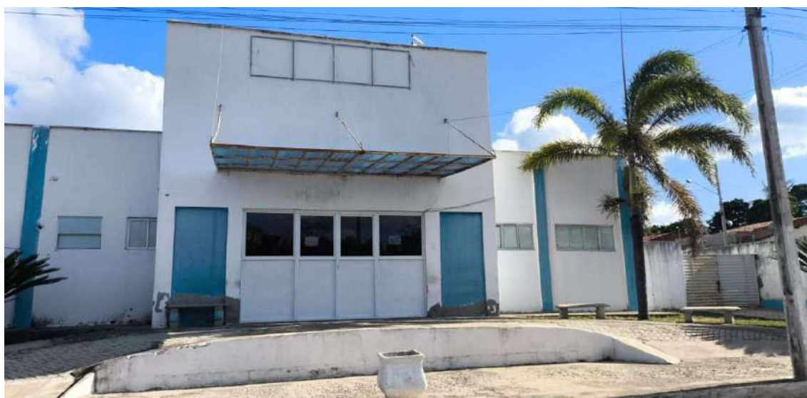
FIGURA 04 - SITUAÇÃO ATUAL: FACHADA DO IMÓVEL
