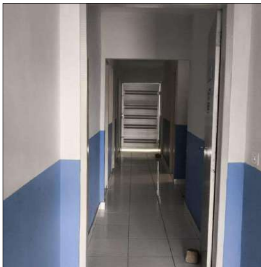
FIGURA 11 - PAREDES INTERNAS: SITUAÇÃO ATUAL
