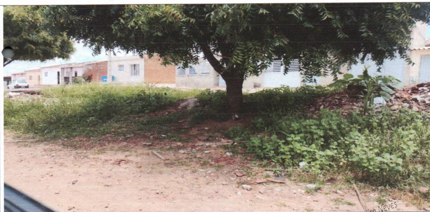
Foto 06 – Situação Atual - Praça na Rua Antônio I. de Holanda no Bairro Malvinas
