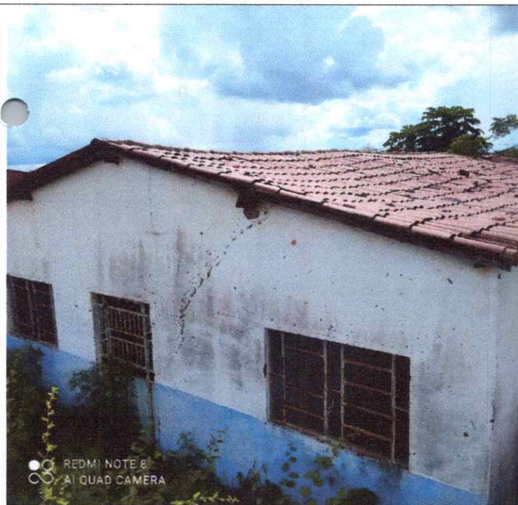
Foto 03 – Prédio do CAPS Rua Padre José Fernandes Zona Urbana
