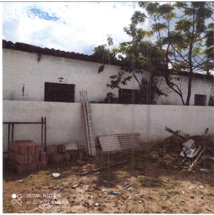
Foto 06 – Prédio do CAPS Rua Padre José Fernandes Zona Urbana
