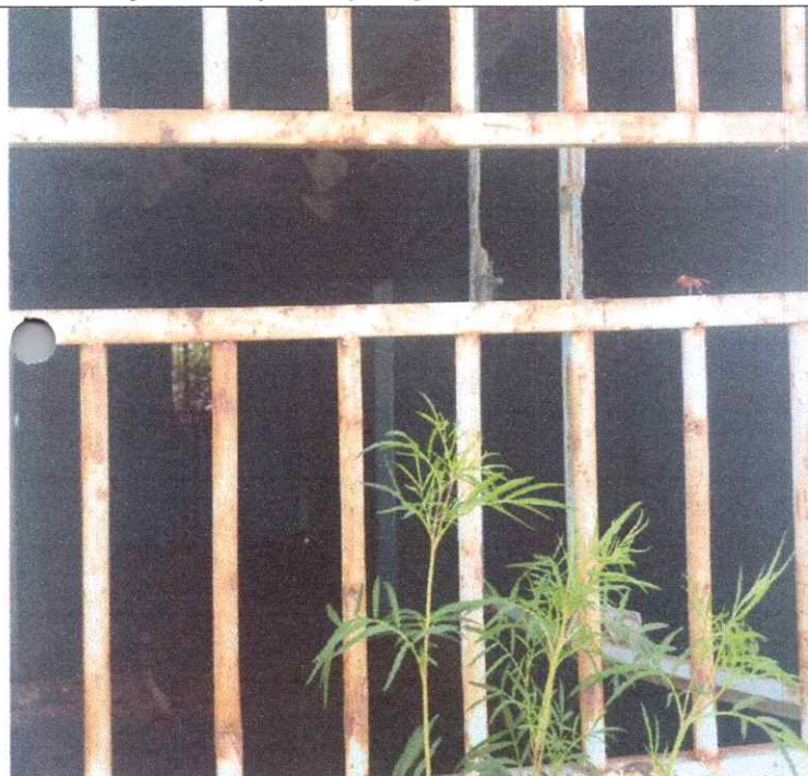
Foto 09 – Prédio do CAPS Rua Padre José Fernandes Zona Urbana
