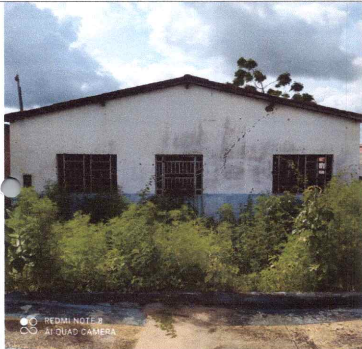
Foto 01 – Prédio do CAPS Rua Padre José Fernandes Zona Urbana
