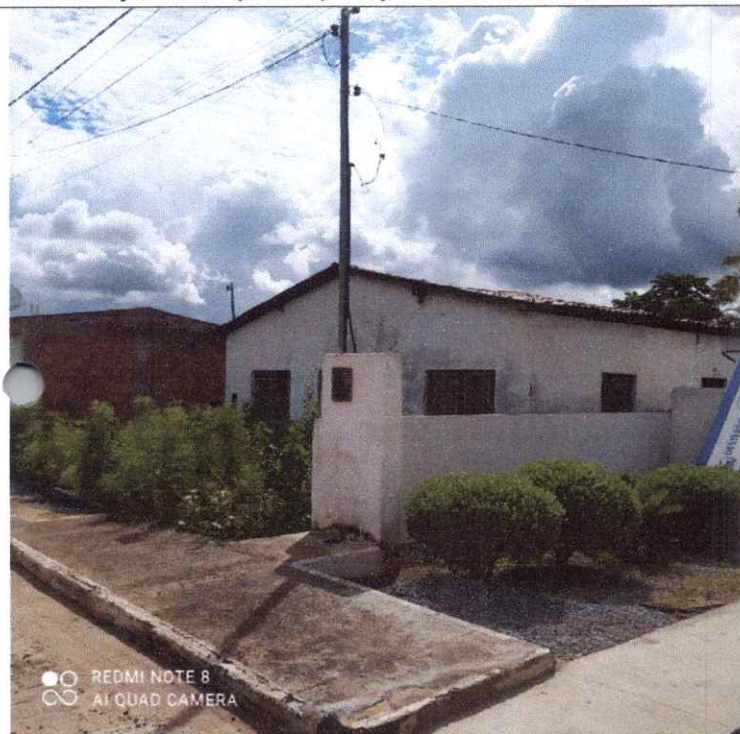
Foto 05 – Prédio do CAPS Rua Padre José Fernandes Zona Urbana
