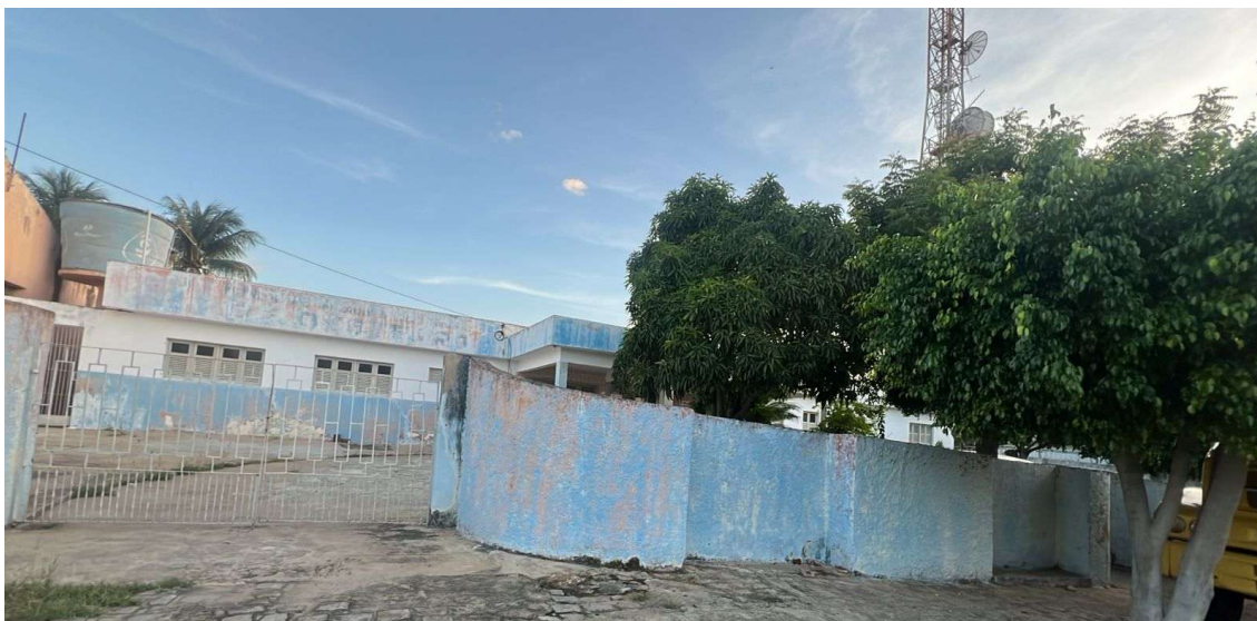
FIGURA 03 - SITUAÇÃO ATUAL: FACHADA DO IMÓVEL
