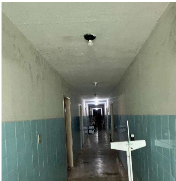
FIGURA 07 - PAREDES INTERNAS: SITUAÇÃO ATUAL
