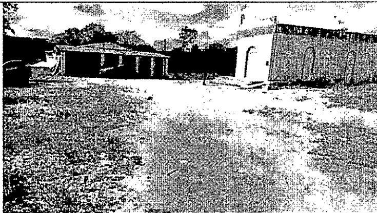
Foto 01 – Pátio que será pavimentado.
