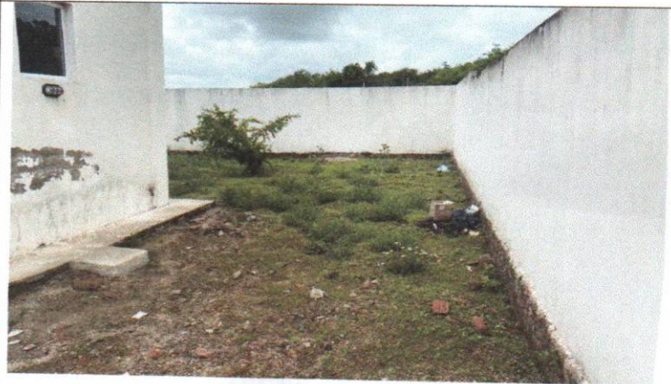
Foto 04 – UBS – Pedra Atravessada - Zona Rural
