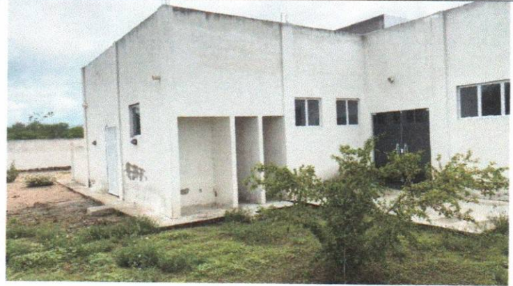
Foto 02 – UBS – Pedra Atravessada - Zona Rural
