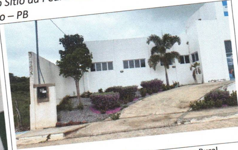
Foto 14 – UBS – Pedra Atravessada - Zona Rural
