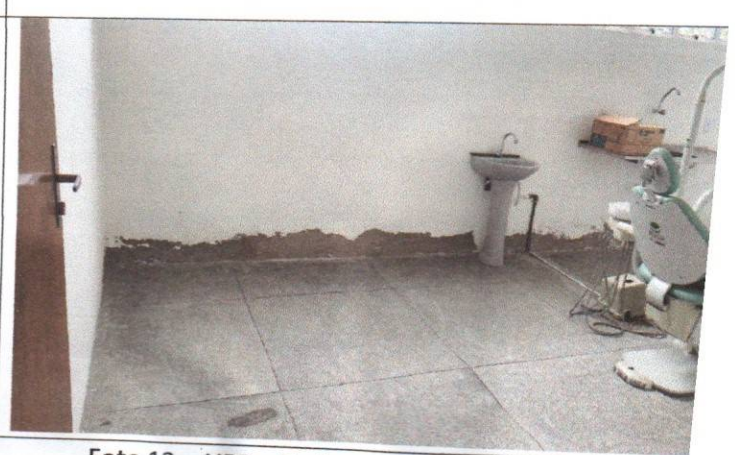
Foto 12 – UBS – Pedra Atravessada - Zona Rural
