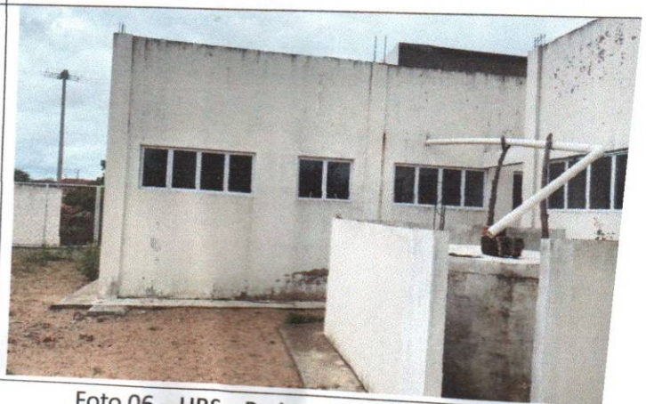
Foto 06 – UBS – Pedra Atravessada - Zona Rural
