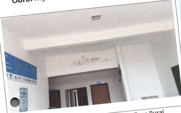
Foto 13 – UBS – Pedra Atravessada - Zona Rural
