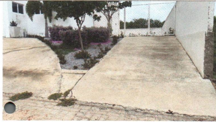
Foto 07 – UBS – Pedra Atravessada - Zona Rural
