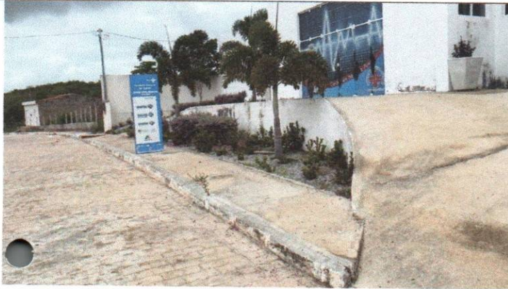
Foto 01 – UBS – Pedra Atravessada - Zona Rural
