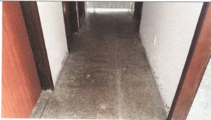
Foto 09 – UBS – Pedra Atravessada - Zona Rural
