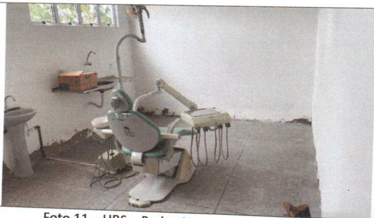
Foto 11 – UBS – Pedra Atravessada - Zona Rural
